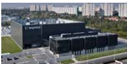
Kampus Beyond.pl z obiektem Data Center 2 – jedno z najbezpieczniejszych centrów danych w Unii Europejskiej, w którym utrzymywany jest trzeci węzeł EPIX w Polsce oraz gdzie działa „Strefa MiŚOT”.
